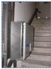
5. Escalera de acceso a la Sacristía Mayor. Adaptación por dispositivo de rail.
