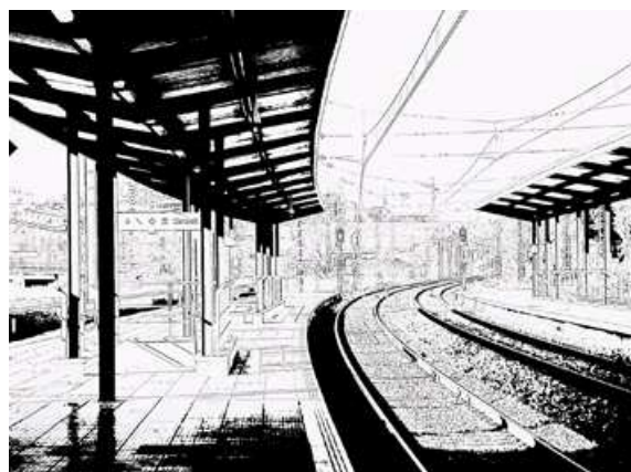
3.17_Estación de Cercanias, Sant Cugat del Vallès
