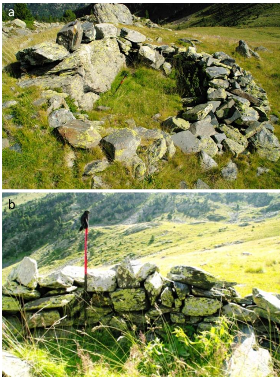
Figura 47: Vista general i alçat del parament interior del mur N.
