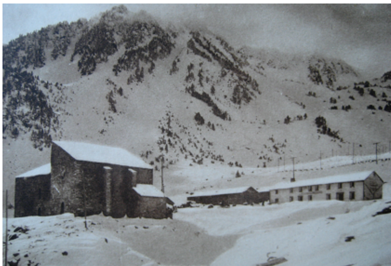
Santuari de La Mare de Deu de Les Ares i Refugi (ca. 1930). Font: Ecomuseu de les Valls d'Àneu
