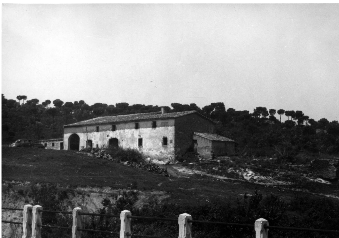
L'hostal de l'Arrupit cap al 1950, amb el camí Ral que baixa a la riera, fotografiat des del pont de nova construcció de la carretera GI-555
