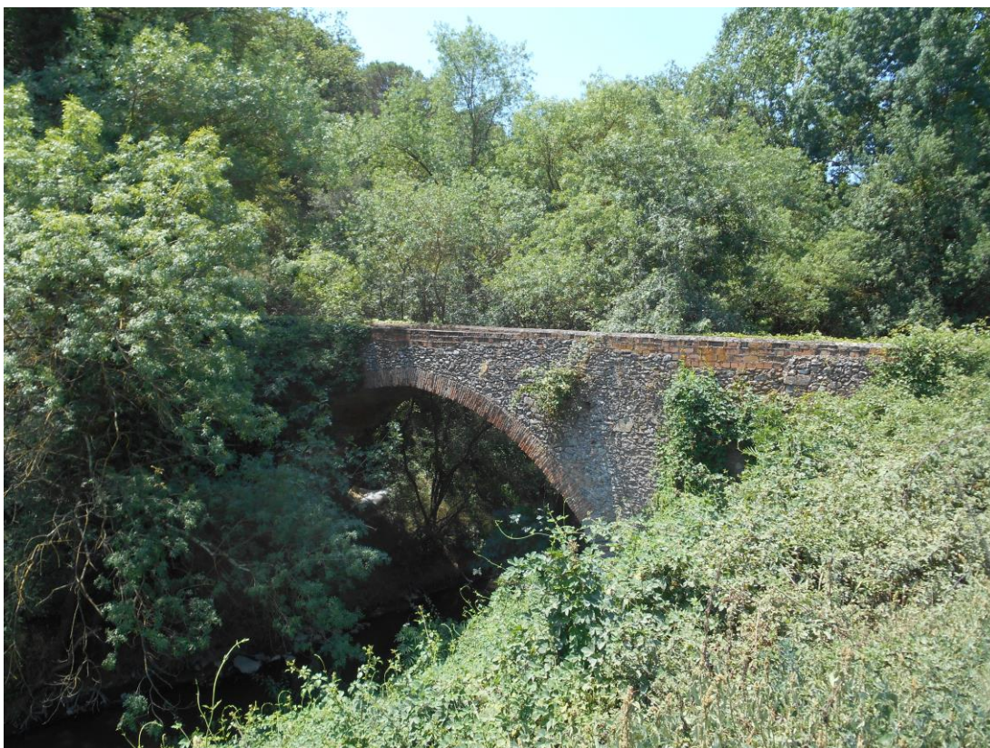
El pont Vell de la sèquia de Sils, cap a Maçanet, abans de la rehabilitació del 2017
