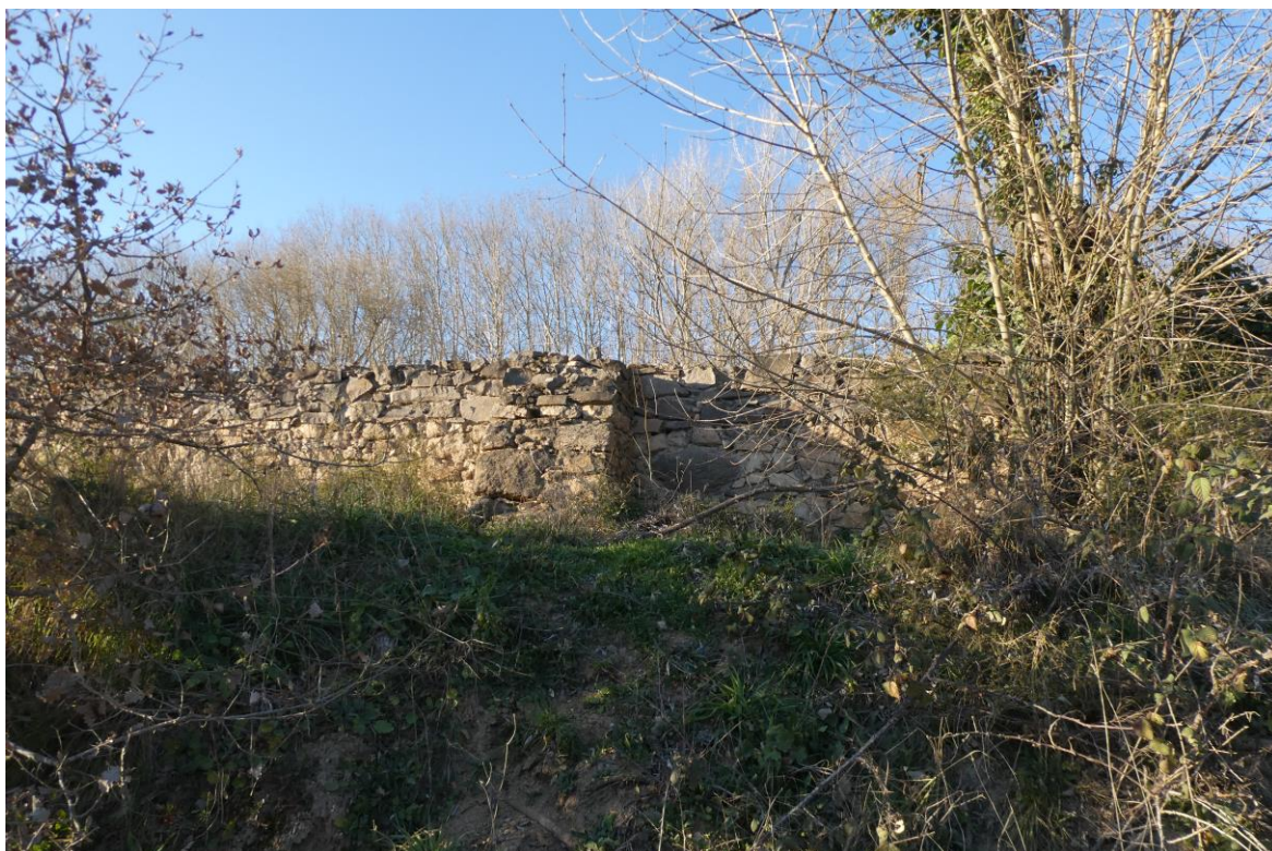
Part exterior del mur de pedra de contenció de la riera: contrafort i mota de terra (2022)
