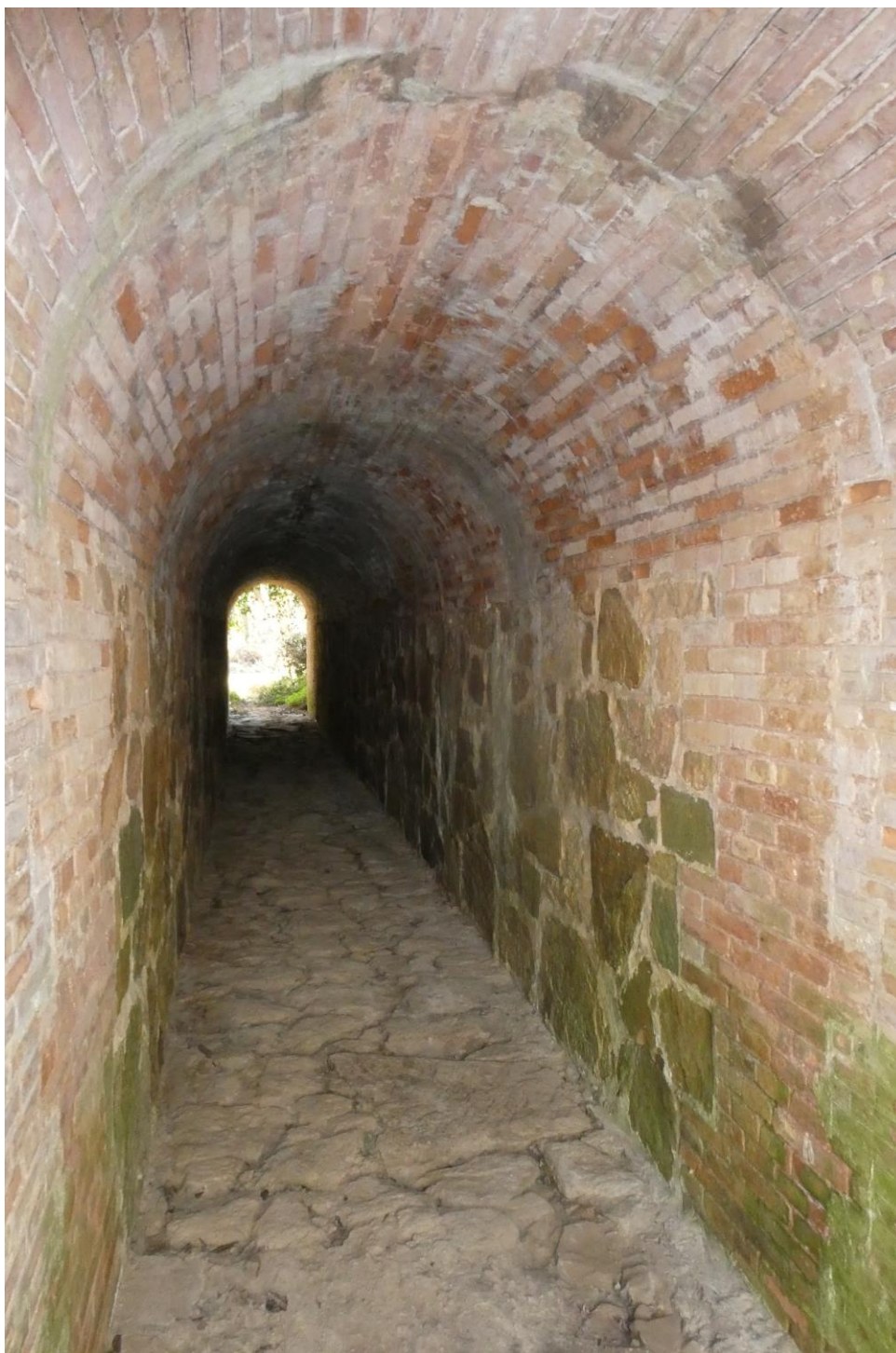
Sota la via de Rodalies, el desguàs del sot de la font de les Closes, cap a la Sèquia, fet de rajols i pedra, a prop de la Canal. També serveix de pas per a persones (2022)
