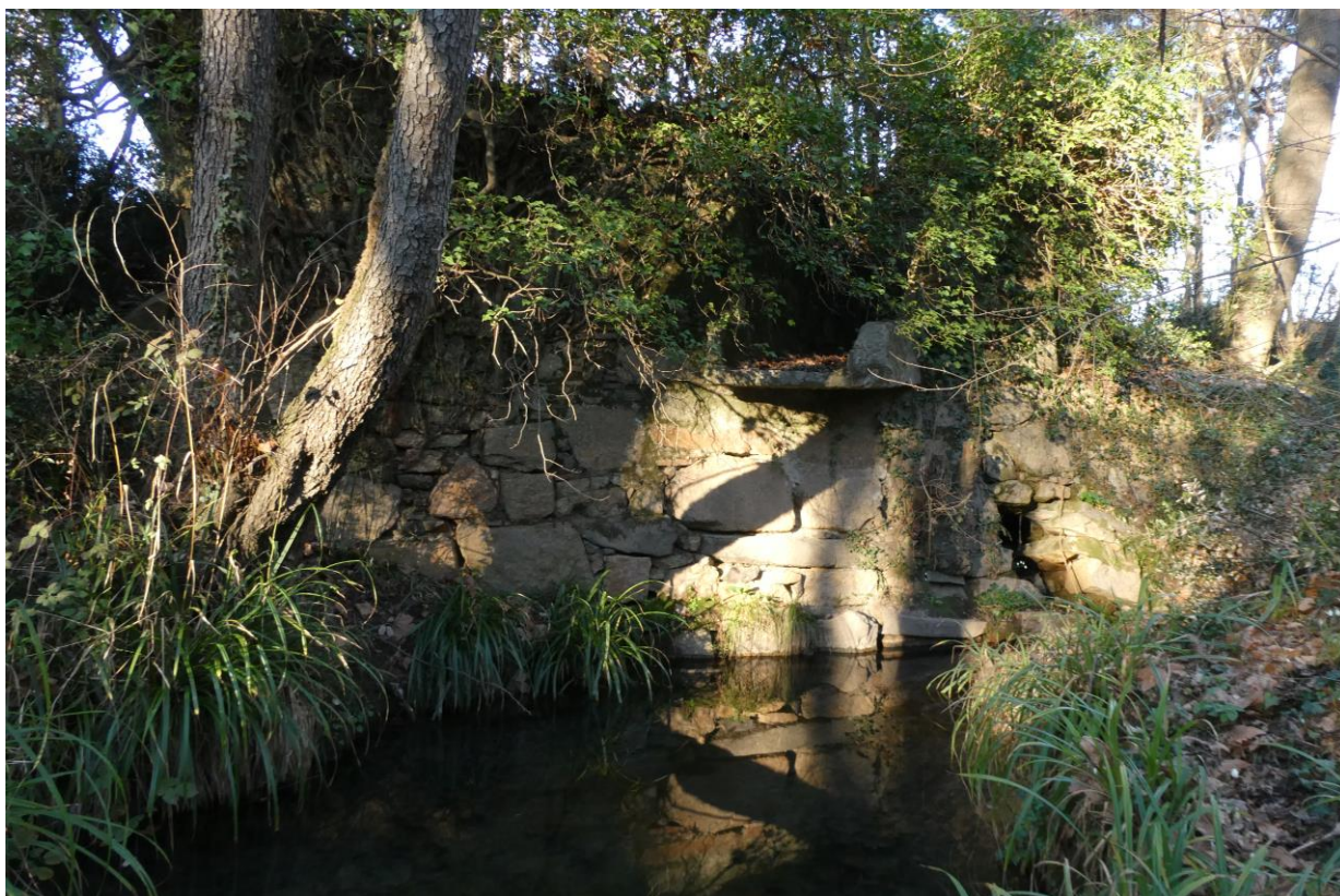
Desguàs final de la canalització de pedra i bassa a sota, a tocar de la sèquia de Sils, a la Canal (2021)
