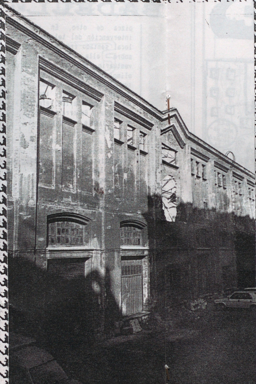
Así quedó DERTEX SA después de incendio.
