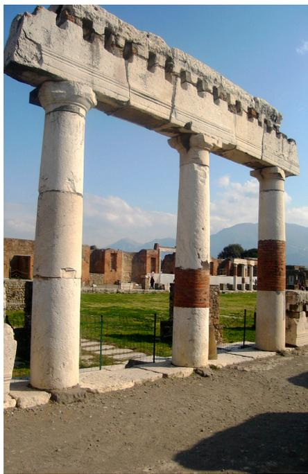
Figura 1. Reparación de columnas con *opus latericium* (Pompeya). Fotografía M. Sanz.
