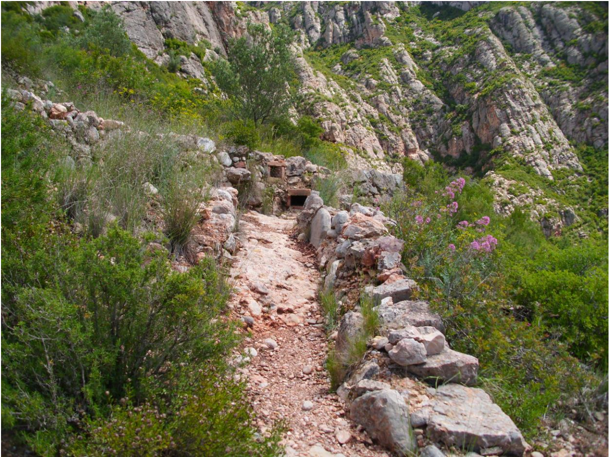
Muros de piedra y desagües de obra, para canalizar el agua de lluvia recogida en una ladera de la vertiente sur de Montserrat
