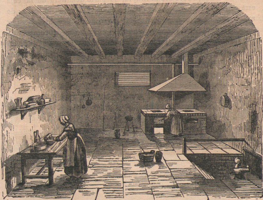
Fig. 35.—Vista interior de la cocina.
