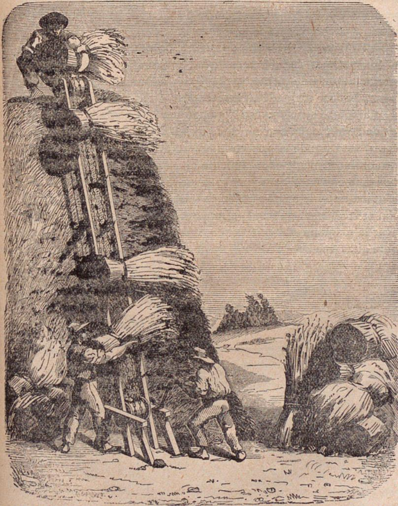
Fig. 58.—Máquina de elevar gavillas.
