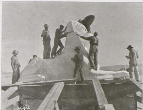
Muntatge d'una de les esfinxs de guix que caracteritza el paisatge escenogràfic d'Egipte, construït a Califòrnia.
