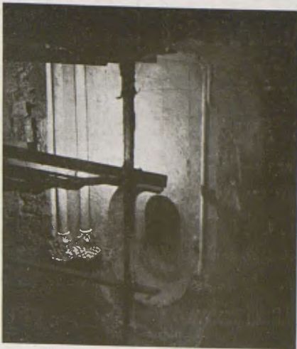
Sant Joan de les Abadesses. Finestral del costat de la Epístola, descobert amb motiu de les obres de restauració.
