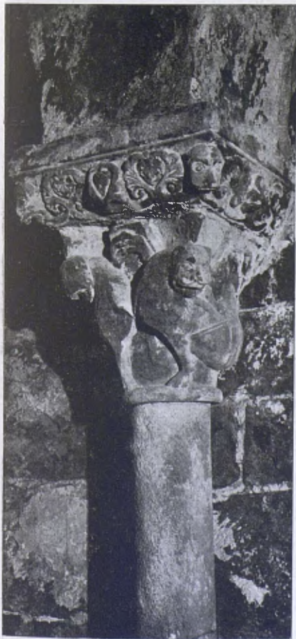
Capitell de la tercera columna de l'àbsis central (Obres de restauració de Sant Joan de les Abadesses.)
