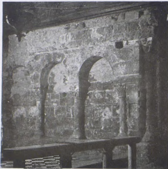
Arcuacions decorant l'interior de l'Absis central de Sant Joan de les Abadesses, aparegudes amb les obres de restauració.
