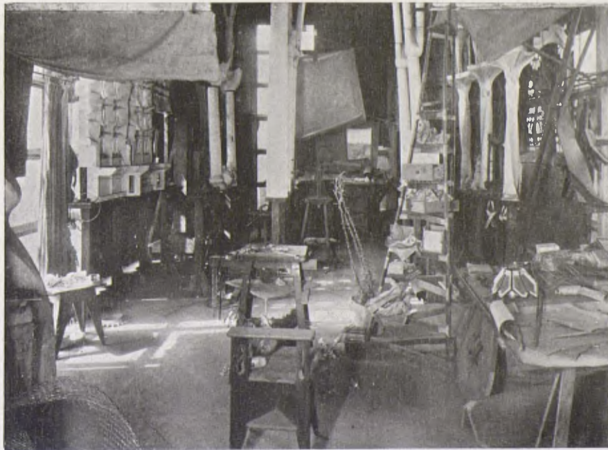
Un aspecte de l'obrador on es veu la maqueta del tros de nau del Creuer de la Sagrada Família, que un cop llest el Portal del Naixement, l'arquitecte Gaudí es proposava d'empendre. (Cl. Ferran.)
