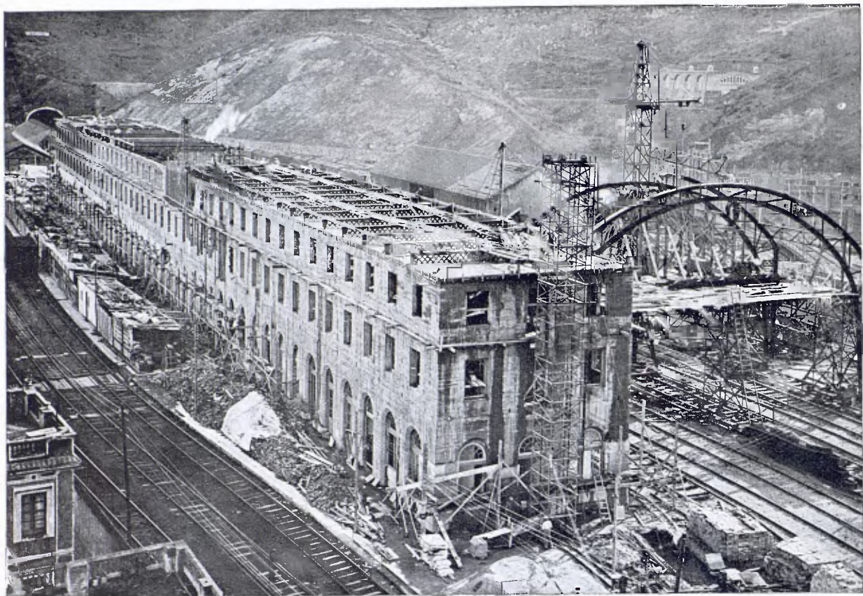
Obres de la nova estació a Port-Bou
