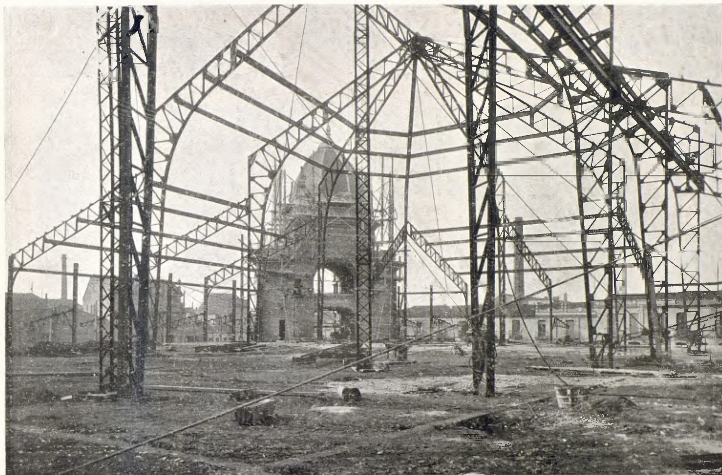
Mercat nou de Sabadell. Construcció metàl·lica de la casa Fill de Miquel Mateu
