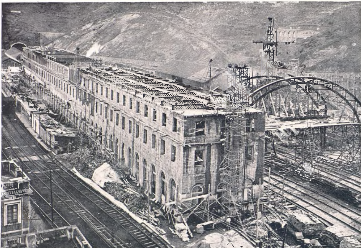
Obres de la nova estació a Port-Bou
