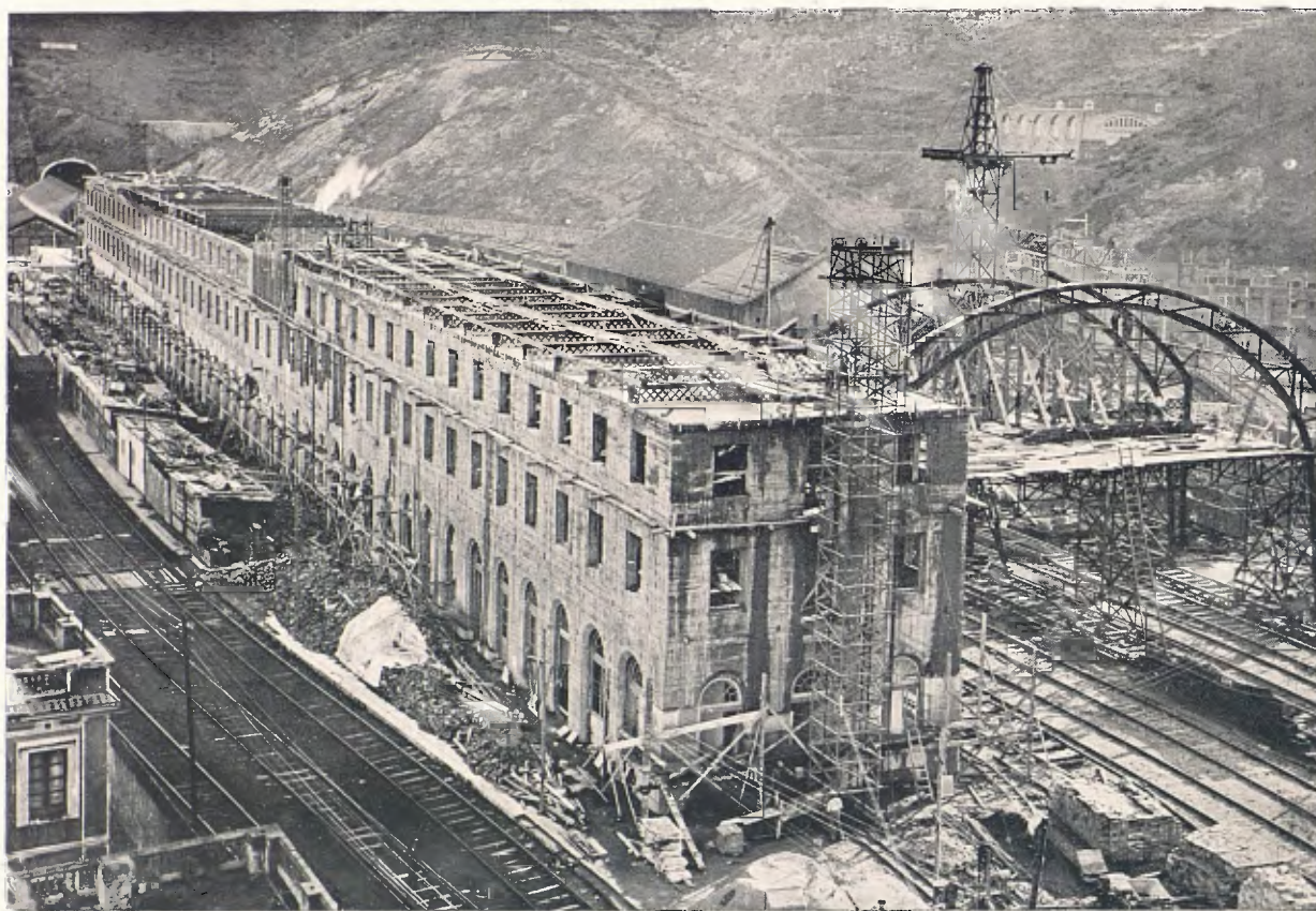
Obres de la nova estació a Port-Bou
