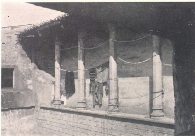
Porxo sobirà de la casa gòtica del carrer de Mercaders (Clixé del Servei de C. i C. de Monuments)
