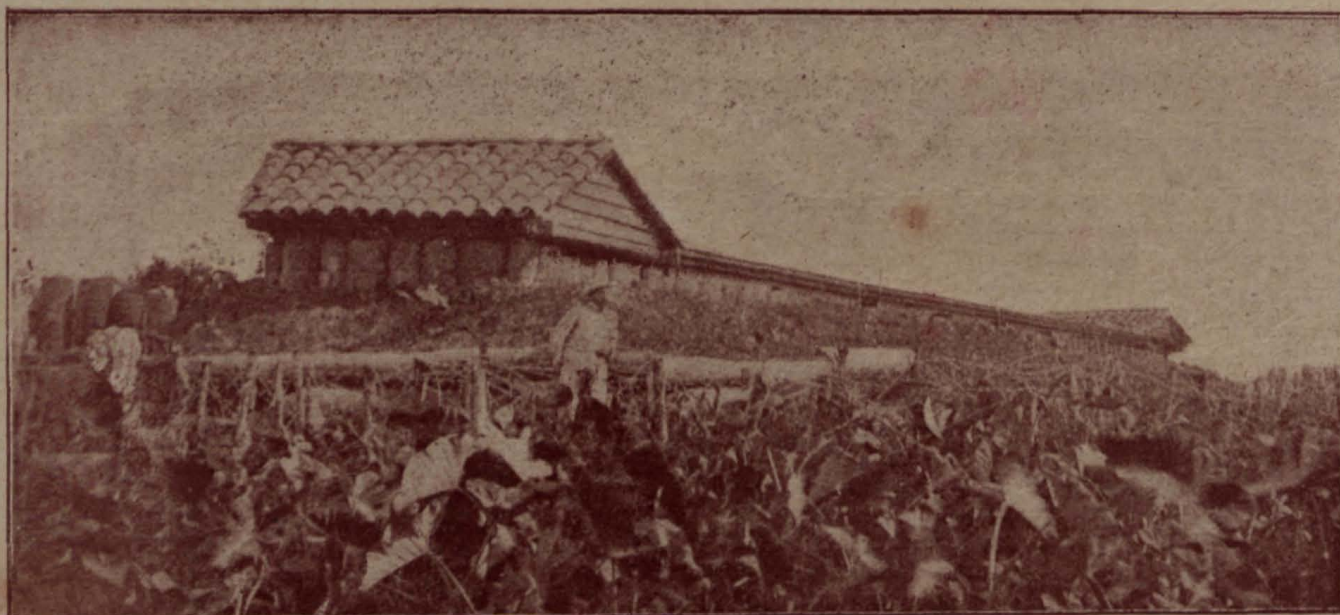
TRINCHERA Y FORTÍN DE LA BARRETERÍA.—PROVINCIA DE PINAR DEL RIO.—CONSOLACIÓN DEL SUR.
