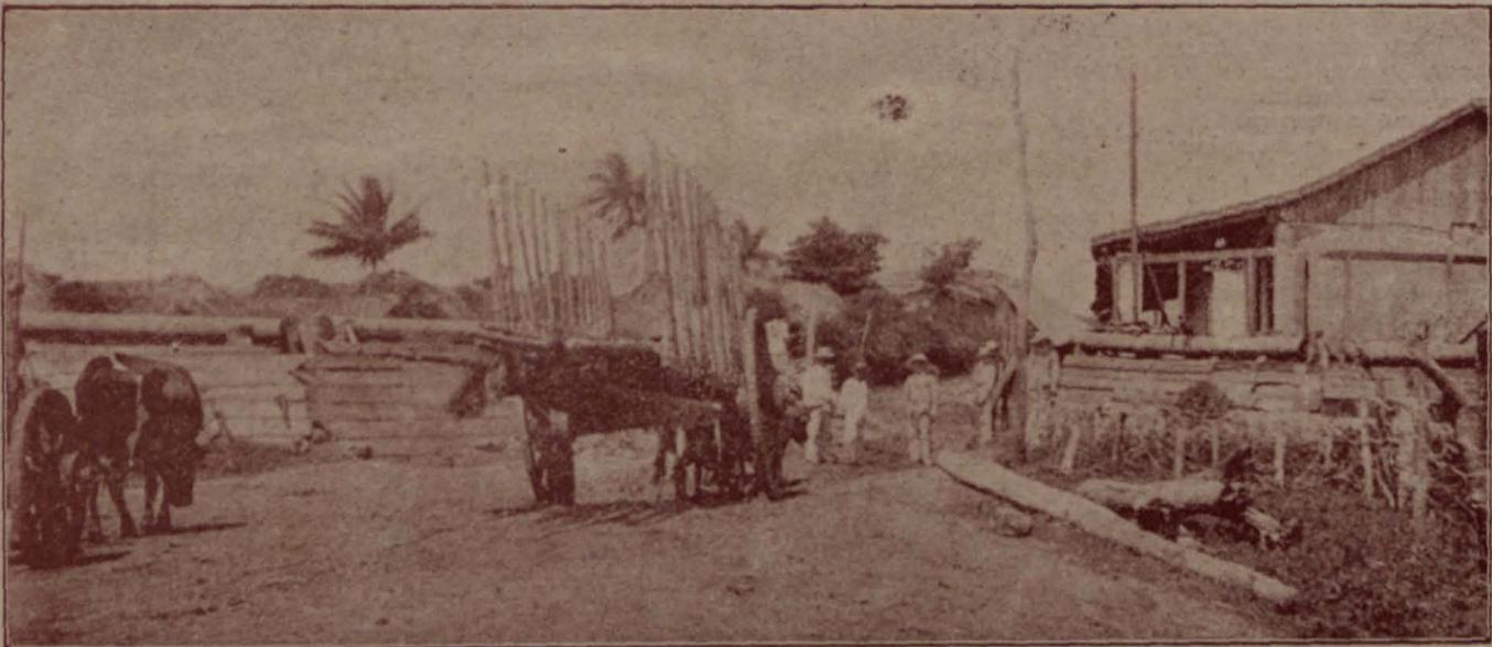
TRINCHERA DE LA ENTRADA DEL PARADERO.—PROVINCIA DE PINAR DEL RÍO.—CONSOLACIÓN DEL SUR
