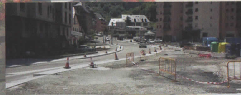
Entrada de Vielha (Carretèra deth Túnel)
