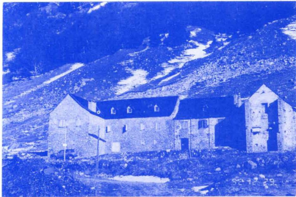
Hospital Boca Sur Tunel. Reformado después del incendio
