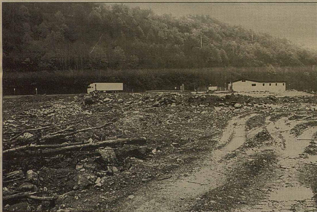
Era gasolinèra ei projectada ath cant dera depuradora d'aigües
