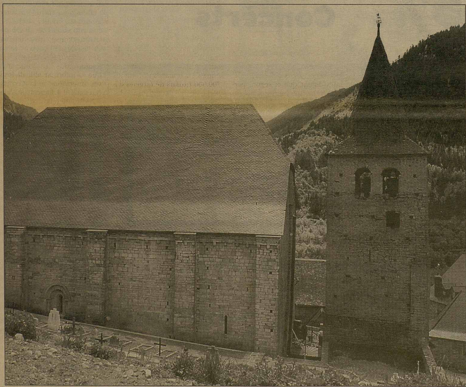
Era glèisa de Cap d'Aran ei en fasa de restauracion
