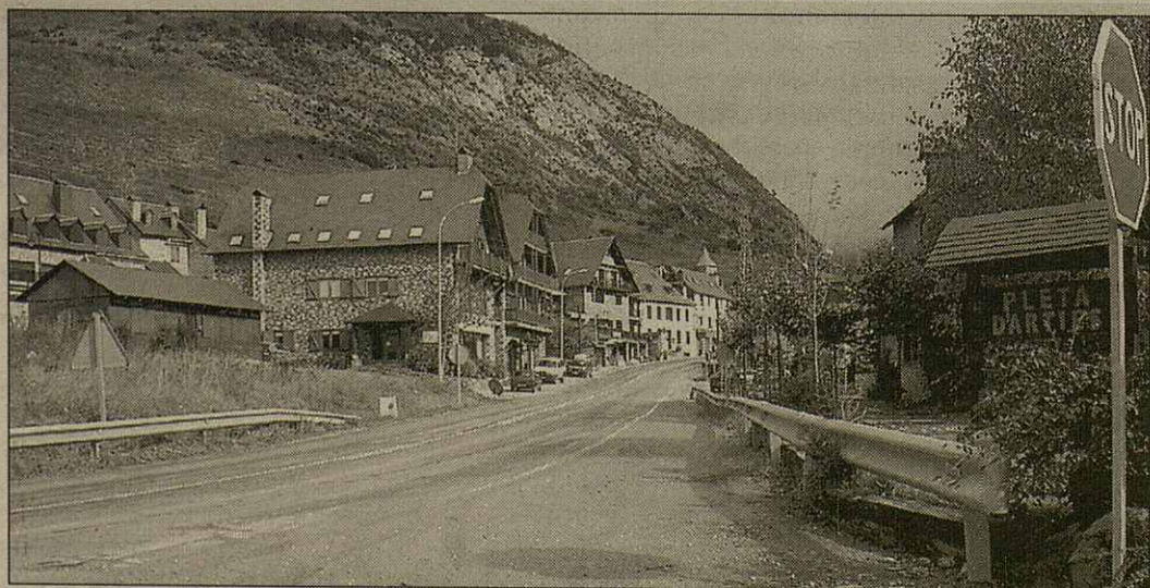
Er Ajuntament deth Naut Aran a invertit ath torn d'uns 30.000 euros en cambiar tot er enluminat dera traubessa d'Arties. Darrèrament er Ajuntament tanben a installat tot er enluminat dera carretèra de Vaquèira e de Salardú.
