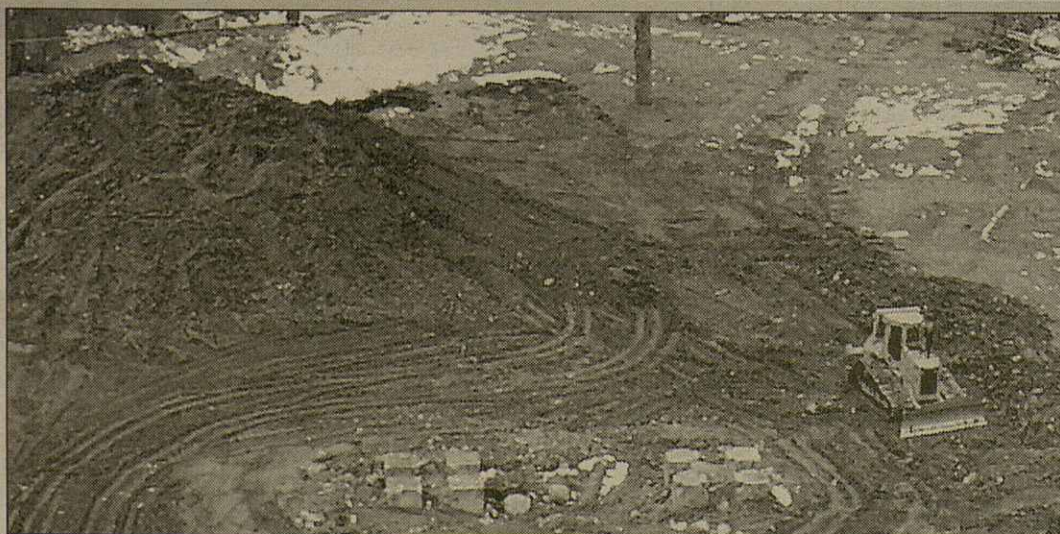
Era darrèra setmana comencèren es trabalhs entà bastir eth parcatge de cinc plantes ena còta 1500 de Vaqueira. Aguest aurà ua capacitat de 2500 places, ues 1500 entàs esquaires e era rèsta entàs proprietaris des apartaments e clients des ôtels que se poguen bastir en aguesta zòna
