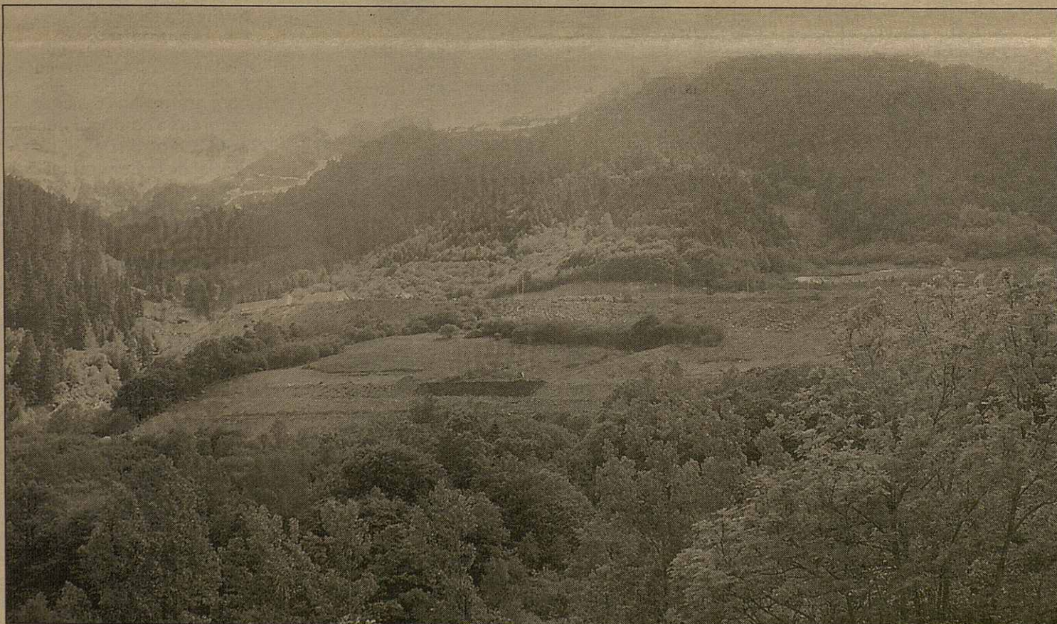
Estat actua des òbres dera boca nòrd deth tunèl de Vielha
