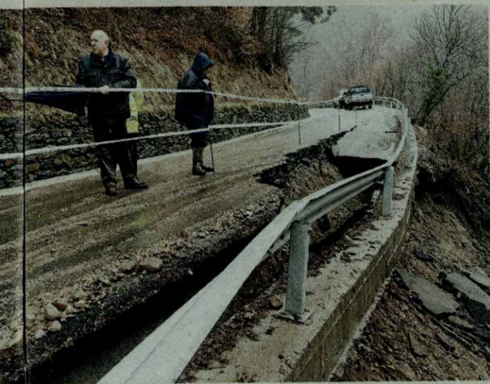
ELS AIGUATS DEL DIUMENGE 22 VAN PROVOCAR TAMBÉ UNA ESSLAVISSADA QUE VA TALLAR 5 HORES LA N-230 A L'ALTURA D'ERA BORDETA, ENTRE VILAMÒS I ARRES
