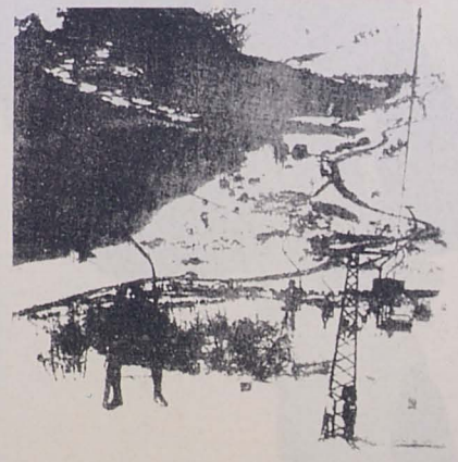
El pasado domingo, en el valle de Arán, se inauguró el telesilla de Baqueira, instalado en las proximidades de Salardú. En el grabado mostramos un aspecto de las primeras pruebas de este transporte, que, con una longitud de mil ochenta metros, salva un desnivel de trescientos sesenta con una capacidad para trasladar quinientas quinientas personas a la hora
