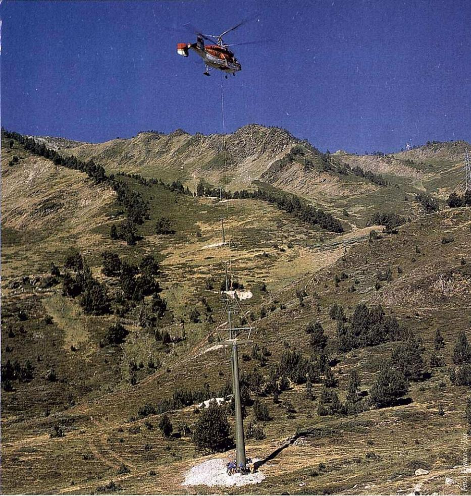
**Las pilonas se colocaron con gran rapidez mediante un helicóptero de transporte**
