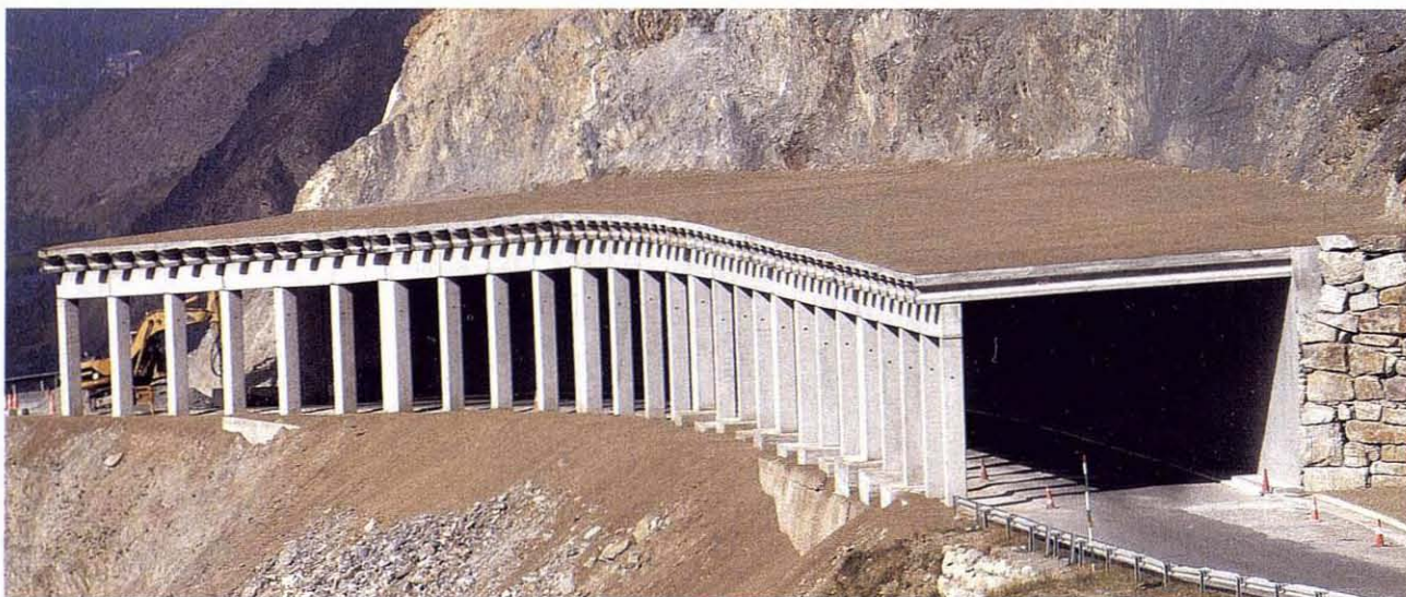
Nueva visera paravalanchas en el Maupàs.
