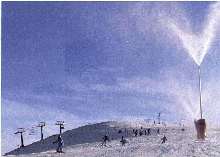
Esta temporada se han instalado 150 cañones de última generación.
