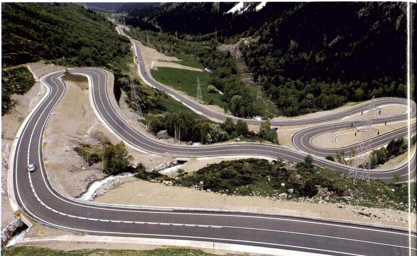
Uno de los tramos remodelados de la C-28
