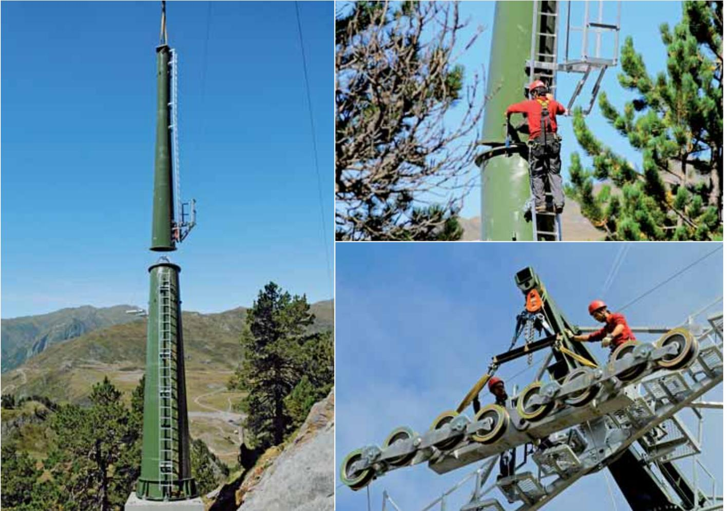
Montaje de las pilonas y mecanismos de arrastre del nuevo telesilla
