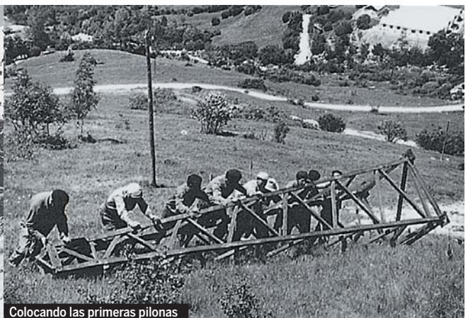
Colocando las primeras pilonas
