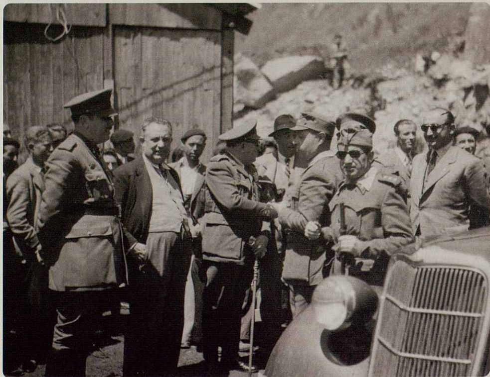
Inauguración túnel boca Nord
