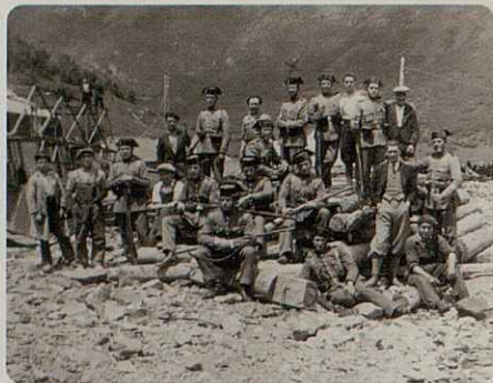
Carrabiners e obrers ena boca Nord
