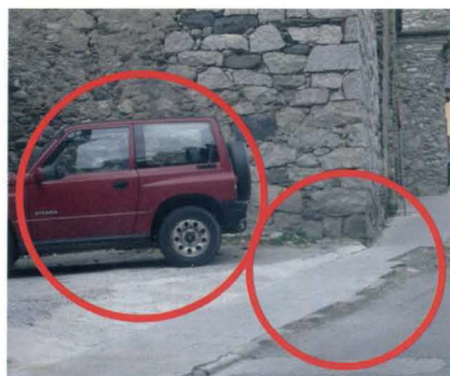
Deterioro de las aceras por subir por ellas.
