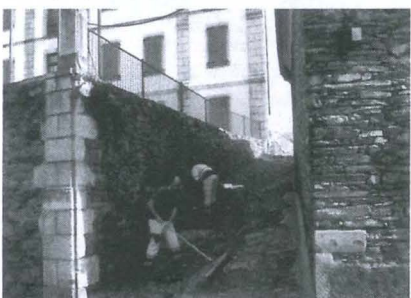
MANTENIMENT DETH MURO DE ARRÒS
