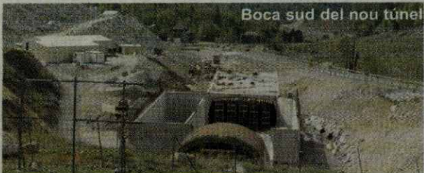
Boca sud del nou túnel
