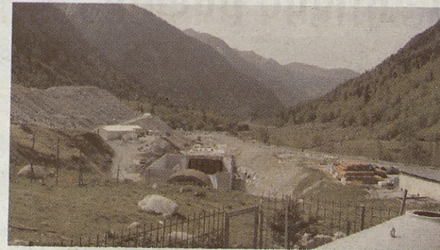
El proyecto de ampliación contempla la zona sud del túnel de Vielha.
