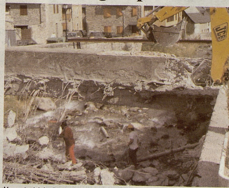
Momento del derribo del antiguo puente Cap de la Vila en Vielha.
