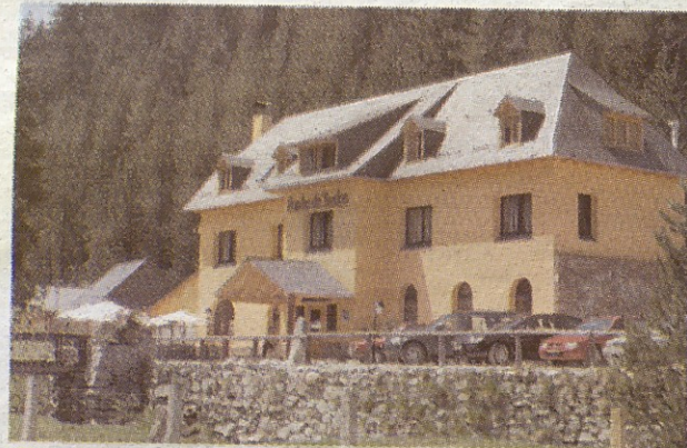
S'amplia la zona d'aparcament dels Banhs de Tredós
