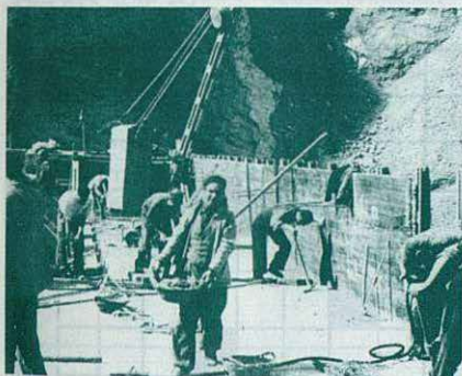
Construcción de la presa de Escales
