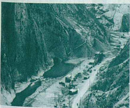
Presa de Escales
