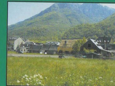
Bossòst: Casa en construcción con terraza y magnificas vistas. Consultar precio.
