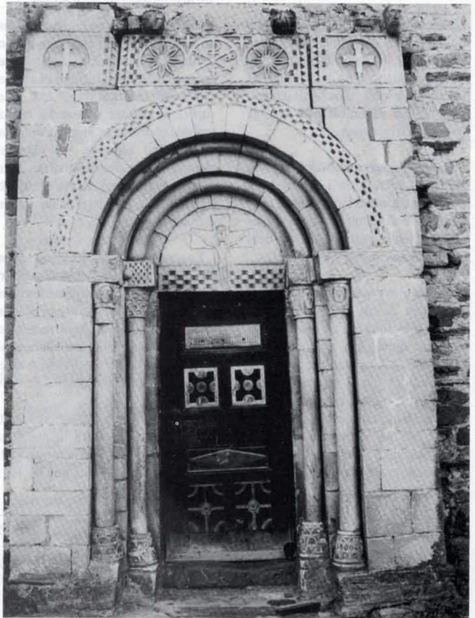
Portalada dera Glèisa d'Escunhau, degut ara sua estructura e era sua esculturacion ei eth element romanic mès interessant e originau deth temple e ua des mès polides dera Val d'Aran.
