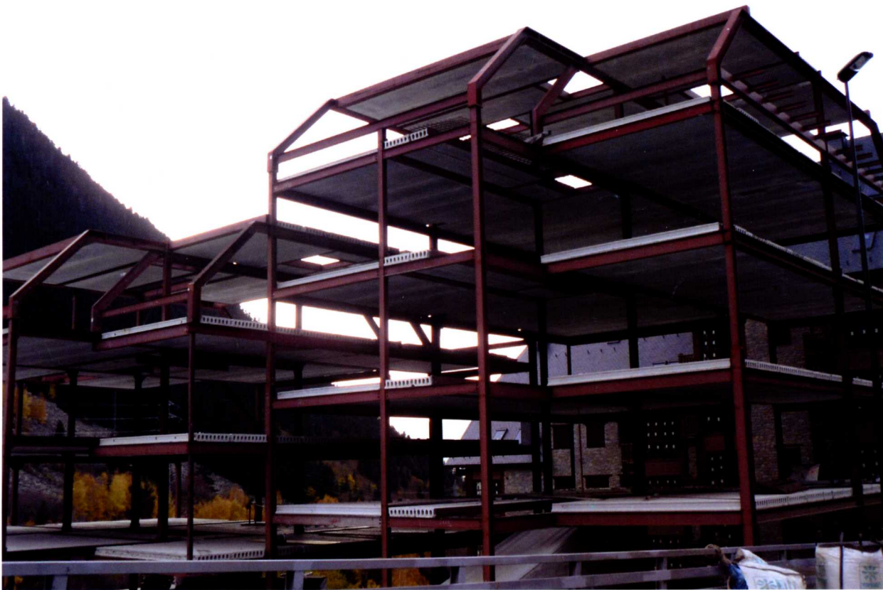
■ Estado actual de la urbanización del Valle de Ruda, con algunas obras paralizadas.
