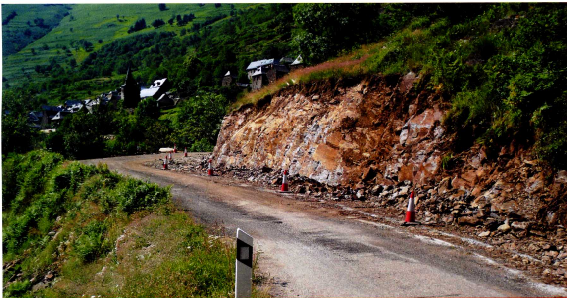
El Gobierno de UA del Conselh Generau está mejorando la carretera de acceso a Bausen, entre otros 15 pueblos de Aran. La inversión global es de 2,8 millones de euros.
