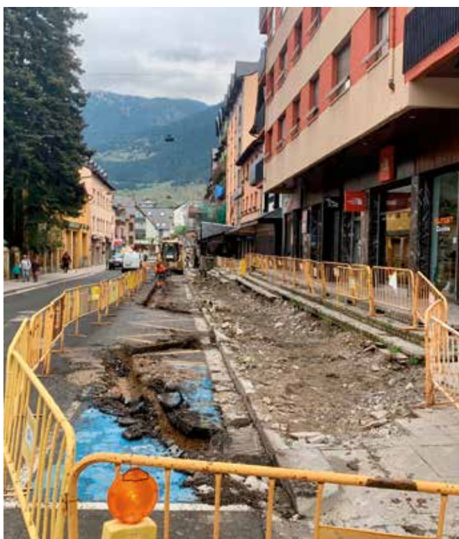
Urbanització i adequació de les voreres de Vielha
