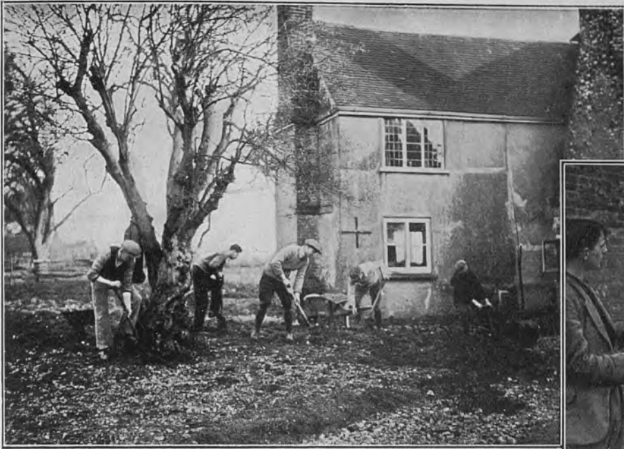
Roturación del terreno alrededor del edificio central
