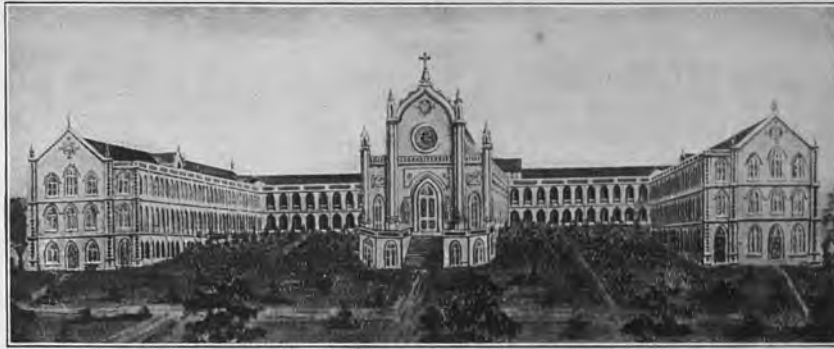
El Seminario de Abwaye (India) en construcción
