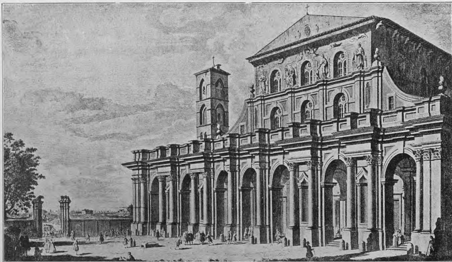
La fachada principal de la Basílica tal como era antes del incendio de julio del 1823
