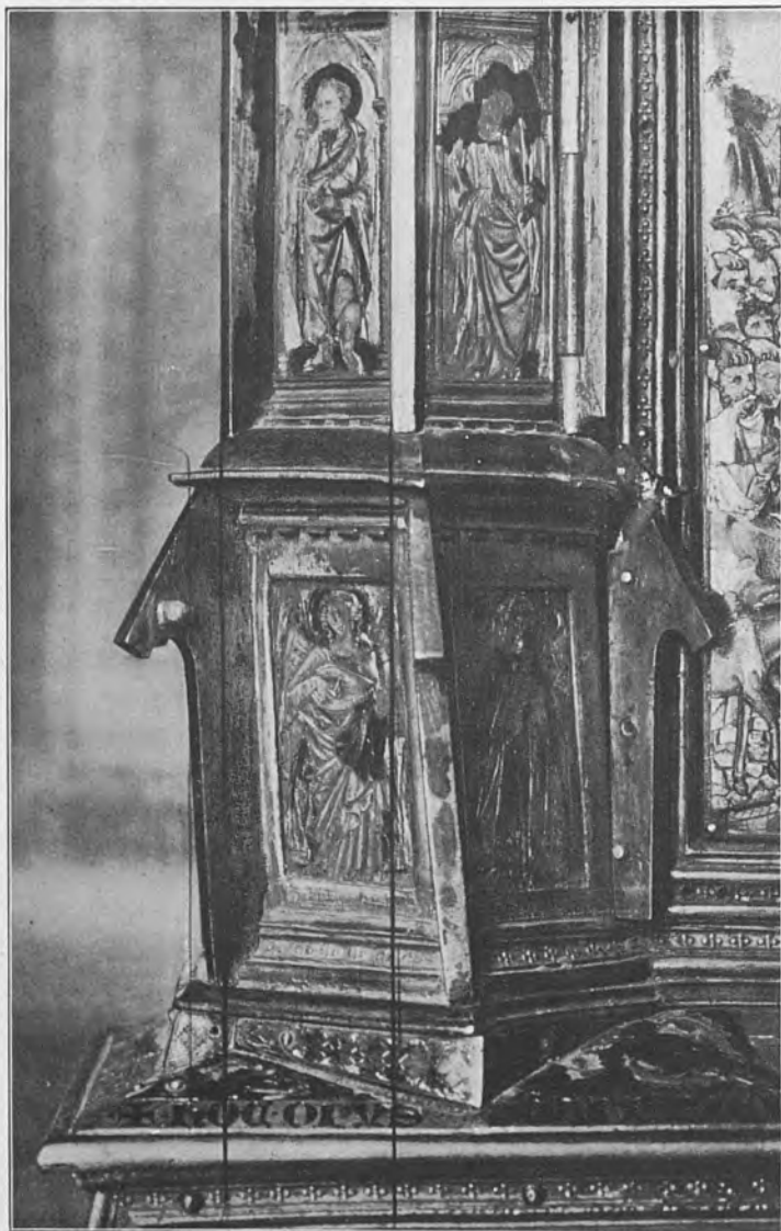
Desplomo en la base de una torrecilla
