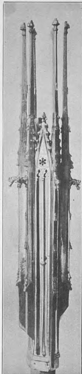
...y después de la restauración de Ravelli
