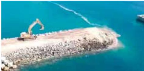
Consiste en la construcción de un dique de 322 m de longitud y alineación NW-SE, perpendicular al muelle de Naos en el puerto de Arrecife, Lanzarote. Dicho dique estará formado por dos tramos diferenciados de distinta tipología:
