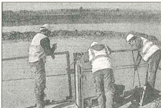
Trabajos de control del agua.
