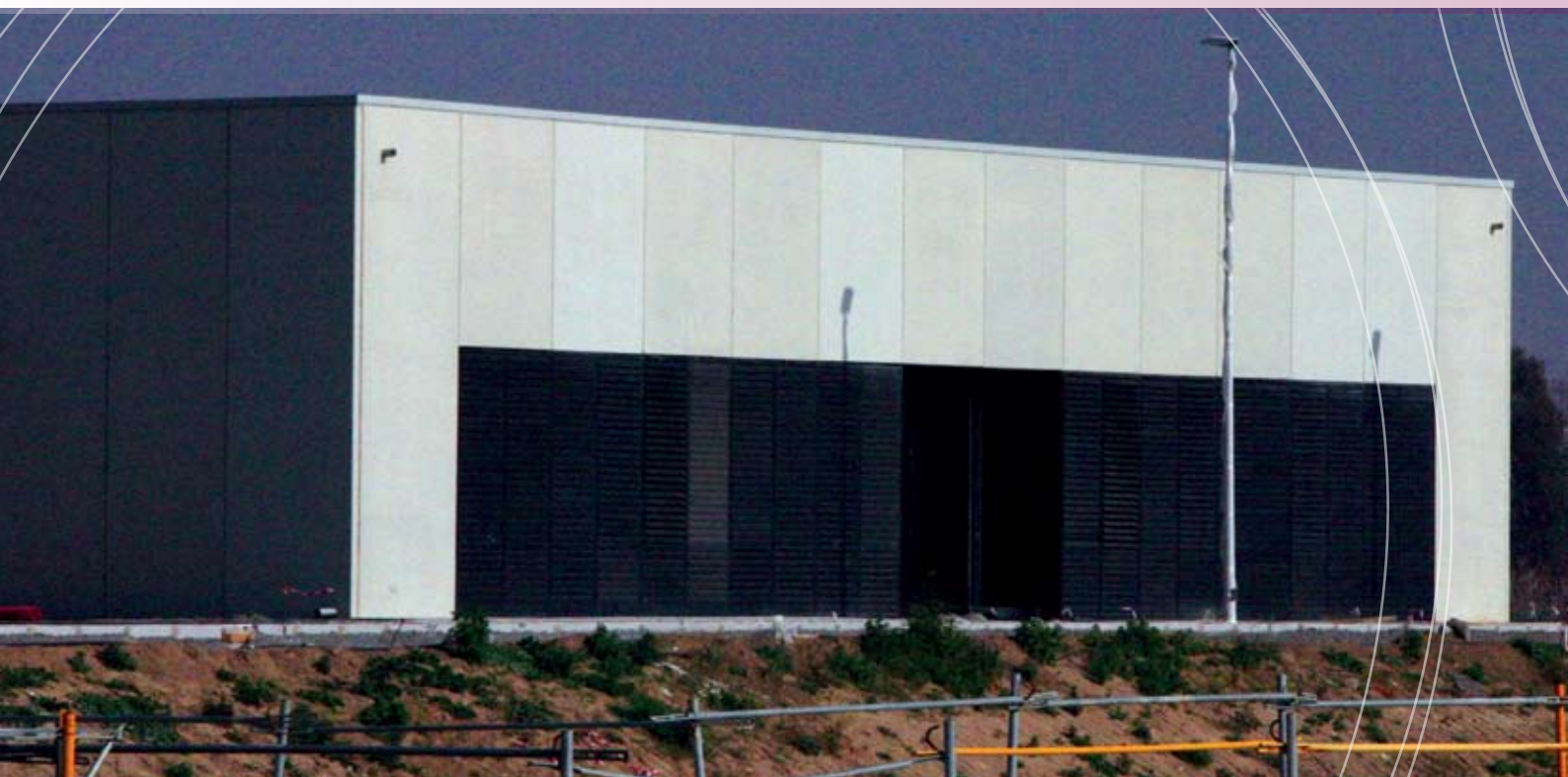
Edificio de maquinaria
