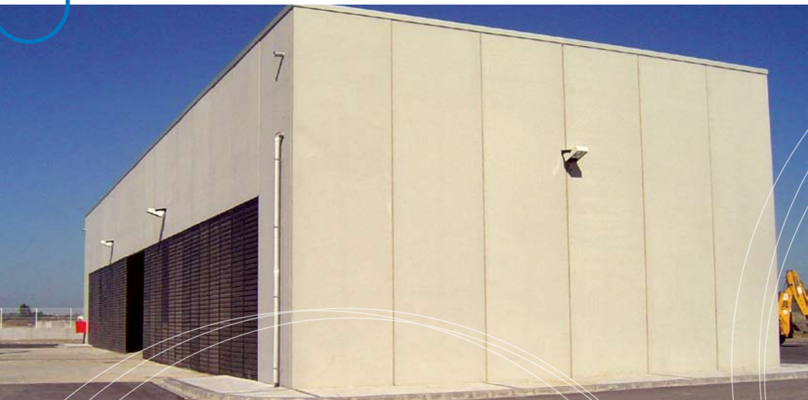
Edificio de taller
