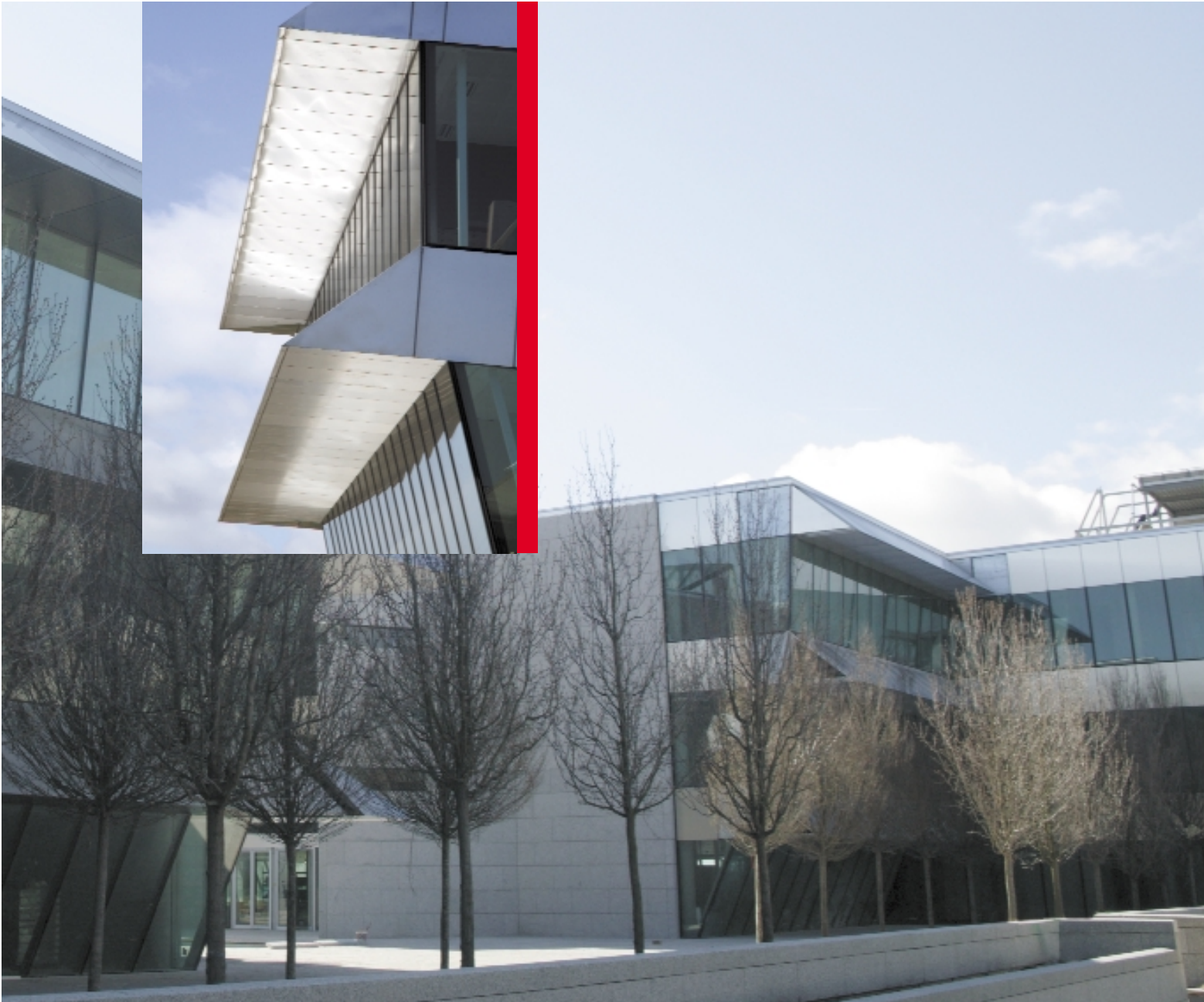
Plaza interior entre edificios Arrecife y Pampa Ciudad Grupo Santander
