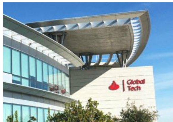
Edificio Alhambra. Boadilla del Monte
